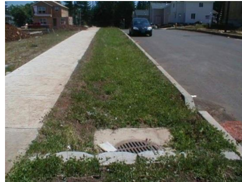
Figur 18: Eksempel på swales/infiltrasjonsgrøft. Tverrsnitt viser grøft nytta langs E39 i Endelausmarka.
