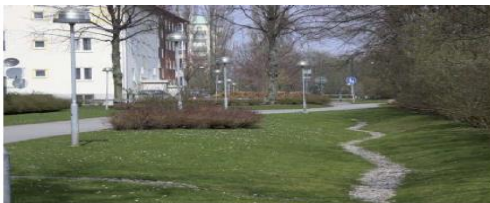
Figur 15: Renne ved boligområde. Kjelde: VA-miljøblad 106. Regnbedd, renner og nedsivingsarealer.
