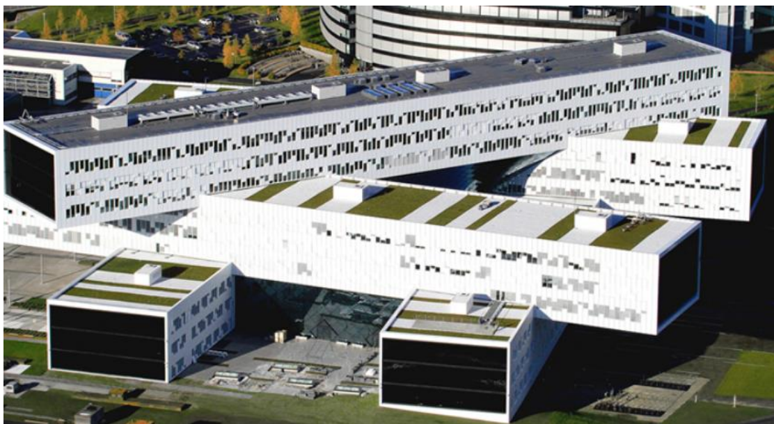
Figur 13: Eksempel på fordrøyning på tak. Her vist ved Statoil sitt regionskontor på Fornebu. Det er brukt sedumplanter og kvit elvestein på taket.
