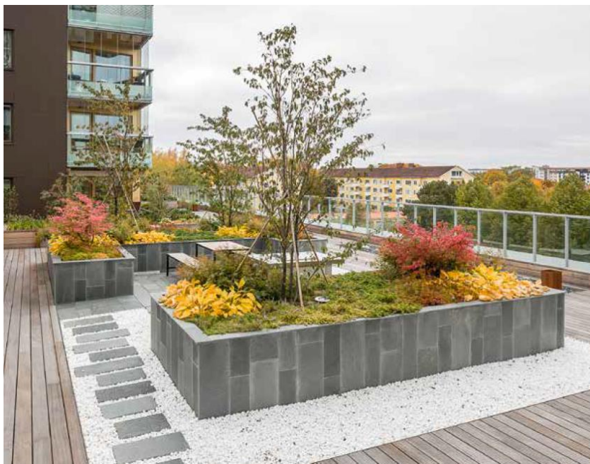
Figur 12: Vekstbedd. Fleksibel på plassering. Djubde på bedda vil i stor grad avgjere evne til infiltrasjon/fordrøyning. Kjelde: Grönatakhåndboka, Vækstbedd og vegetasjon, 2017
