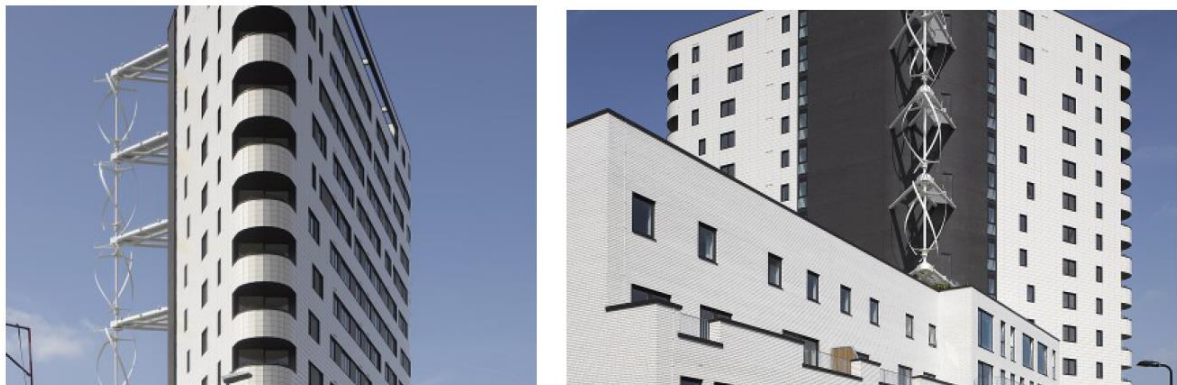
Figur 13: Vertikale vindturbiner i en vindforsterkende bygningsløsning, leilighetskompleks
